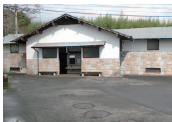
深江グラウンド駐車場トイレ
