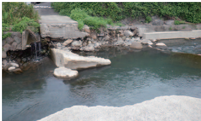
亀洲の潜水橋
