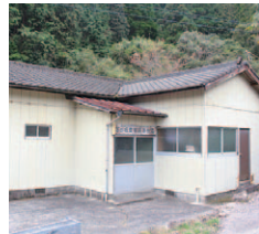
西有家塔の坂農事研修施設
