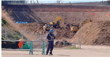
大亀矢代トンネル
