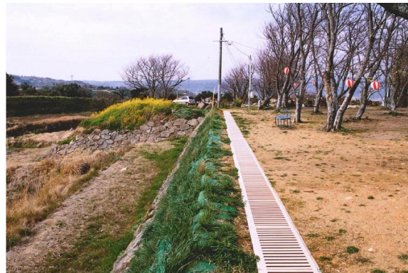
写真 3-4 (5) 石垣 18 天端側植生土のう保護工・排水溝設置
