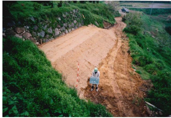
写真 3-2 (2) 石垣 7 裾側保護盛土工
