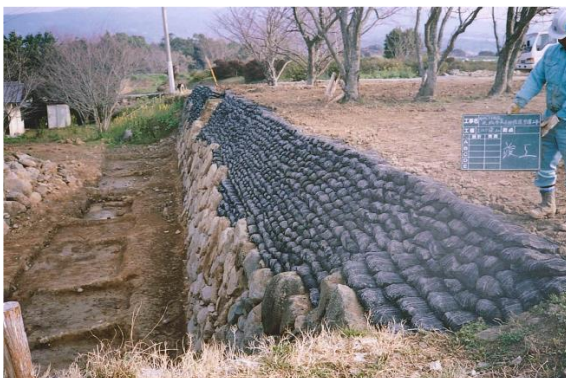
写真 3-5 (8) 石垣 14 天端側植生土のうによる保護工
