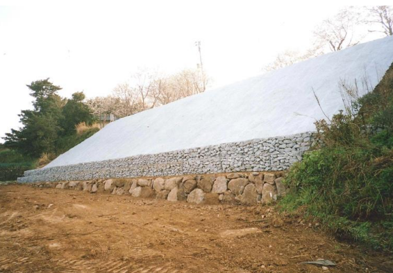
写真 3-7 (11) 石垣 14 裾側保護盛土工・フトン籠工・植生工
