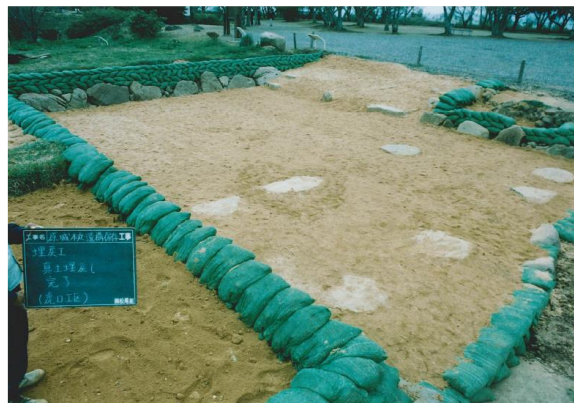
写真 3-8 (13) 本丸門跡内部真砂土保護工
