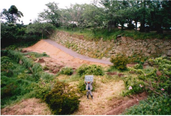
写真 3-1 (1) 石垣 4 裾側保護盛土工・仮歩道設置
