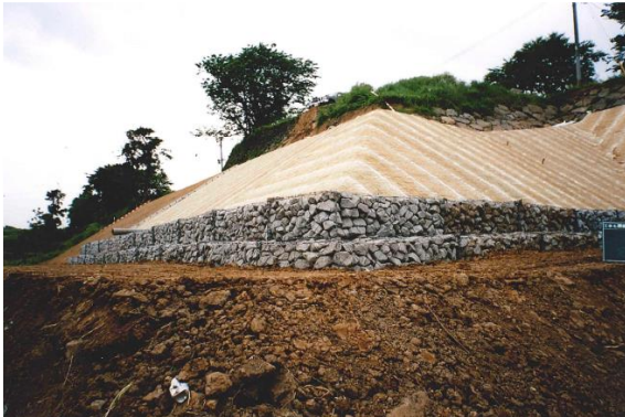
写真 3-3 (3) 石垣 18 裾側保護盛土工・フトン籠工
