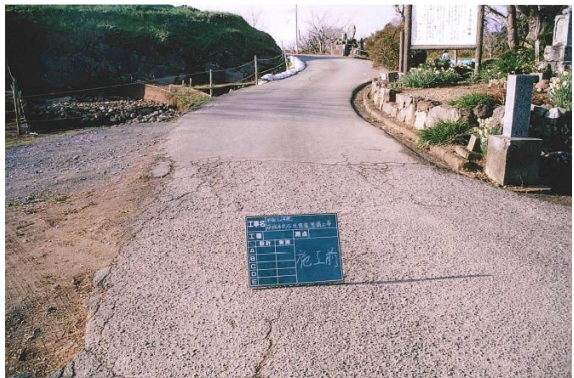
写真 3-6 (9) 既設アスファルト道路撤去・砕石敷き工
