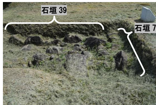
写真 5-5 石垣 7・39 内隅の破却箇所
