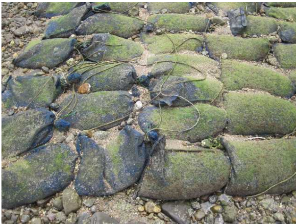
(砂利バック設置の様子)
