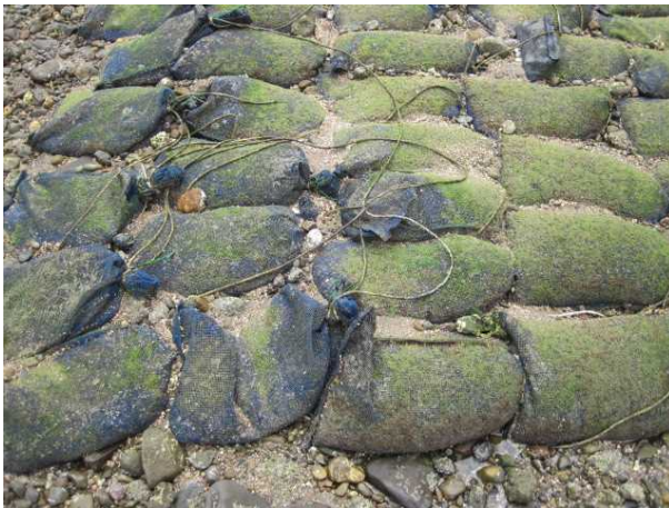
(砂利バック設置の様子)
