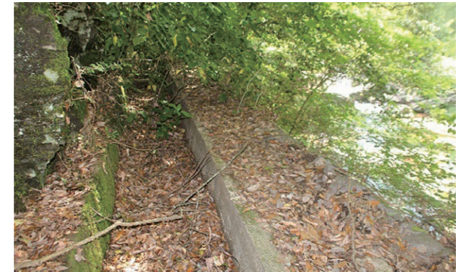
発電用に水を引くための導水路
