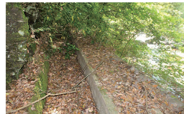
発電用に水を引くための導水路
