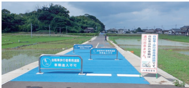
一部の交差点に注意看板を設置しました
