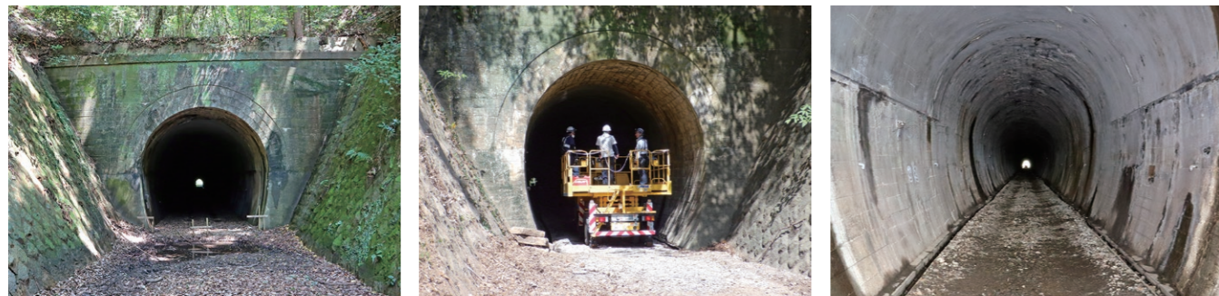
工事施工前(口之津町側から)
