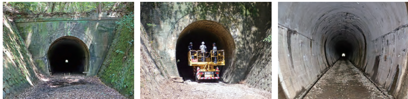
工事施工前(口之津町側から)
