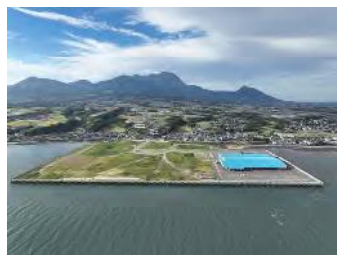
堂崎港埋立地
