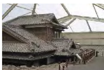
土石流被災家屋（ジオサイト）
