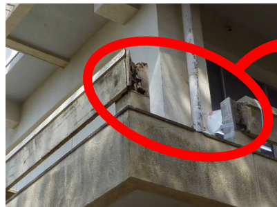
老朽化により手すりが落下
