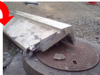
老朽化により手すりが落下
