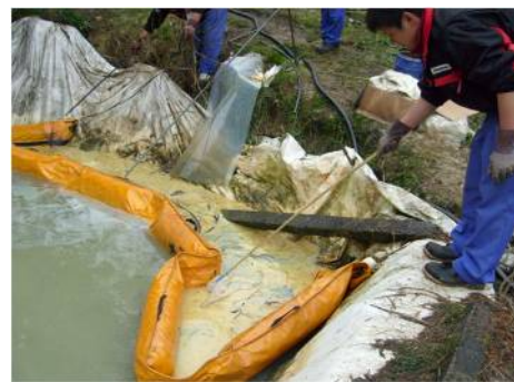
③. 重油の回収作業
