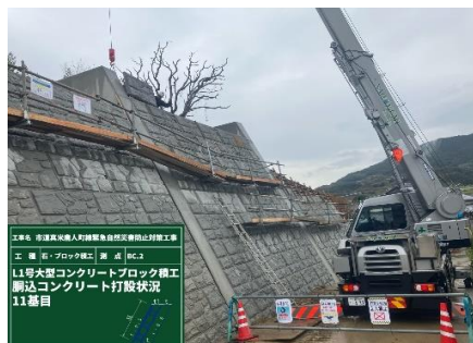
大型ブロックの施工
