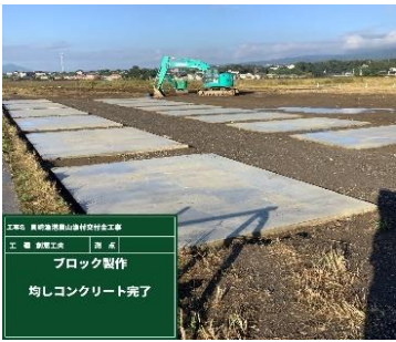
均しコンクリート
