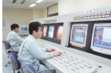
南有馬衛生センター室内
