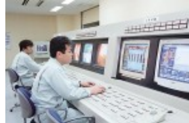
南有馬衛生センター室内
