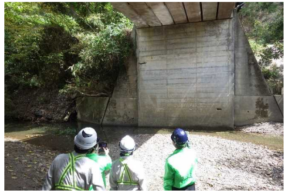
ドローンを用いた点検例
