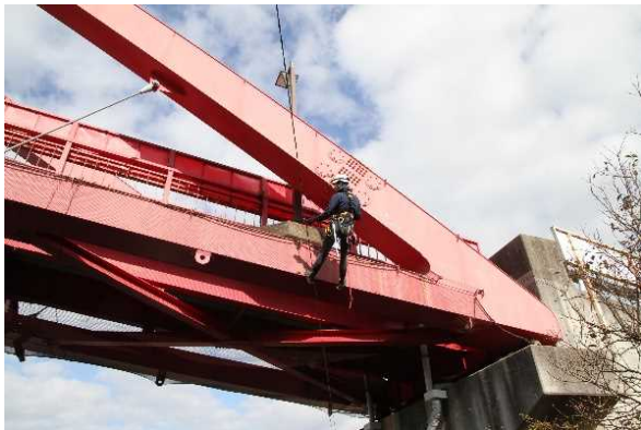
ロープアクセスによる点検 (R1 点検時)
