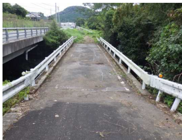
折木橋 現況写真
