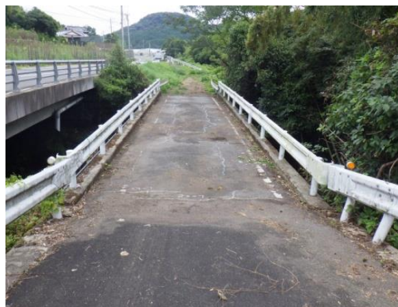
折木橋 現況写真
