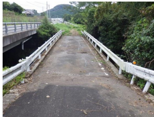
折木橋 現況写真
