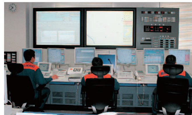
■ 3階 高機能消防指令センター
