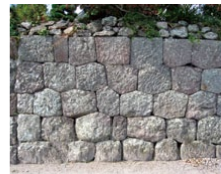
武家屋敷に見られる代表的な石垣。 ・下2段が「打ち込み接ぎ・布積み」 ・上3段が「切り込み接ぎ・異形亀甲積み」という積み方。 ・最上段には乱雑に積まれた「つづて石」も乗っています。
