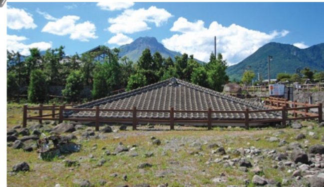
「土石流被災家屋保存公園」に保存されている家屋群。 1階部分がほとんど埋まっています。
