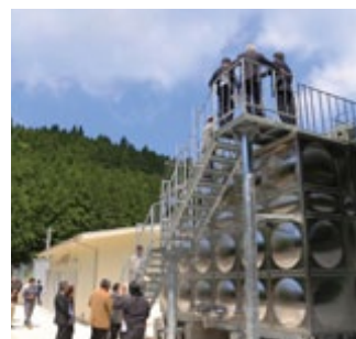
『塔ノ坂地区住民待望の給水開始』 まちの話題(6～8)
