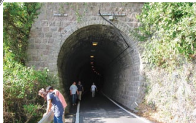
旧小濱鉄道千々石第二トンネル。今にも蒸気機関車が走り出さそうです。
