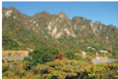
天狗山の崩壊地。切り立った崖は、今も少しずつ崩れ続けています。
