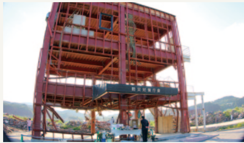
南三陸町「防災対策庁舎」
