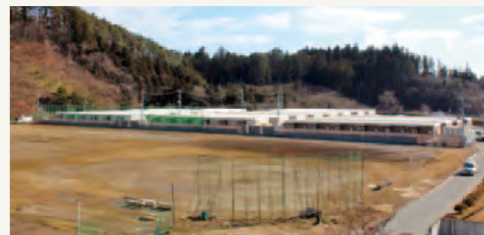
中学校グラウンドに建設されている仮設住宅
