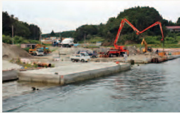
復旧作業が進む歌津泊漁港
