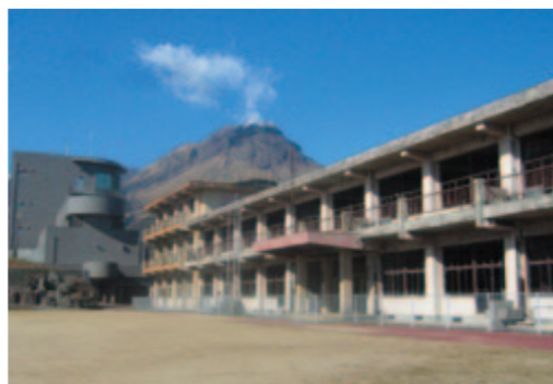
旧大野木場小学校被災校舎
