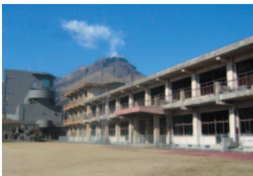
旧大野木場小学校被災校舎
