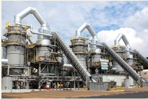
完成した震災がれき焼却施設
