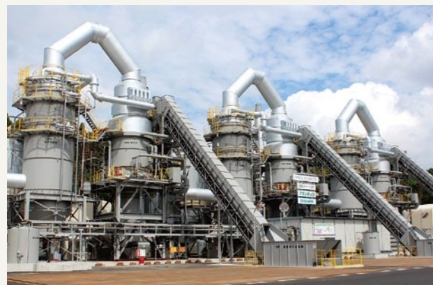
完成した震災がれき焼却施設
