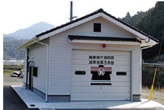
●加津佐地区第3分団詰所 場所：加津佐海洋センター駐車場地内 構造：木造平屋建 延床面積：53.36㎡
