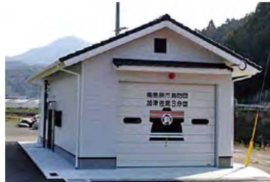
●加津佐地区第3分団詰所 場所：加津佐海洋センター駐車場地内 構造：木造平屋建 延床面積：53.36㎡
