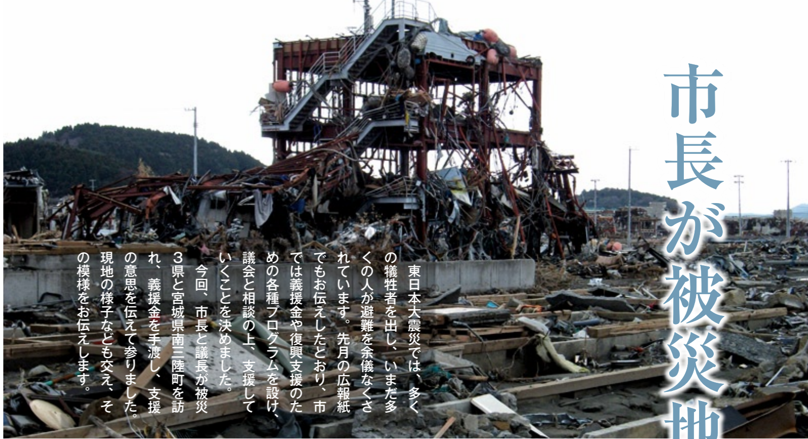
↑宮城県南三陸町役場付近。「骨組み」のみの防災センターだけが立つ。
