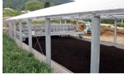
整備された家畜排出物の堆肥化施設(西有家町)。発酵熟成された高品質の堆肥は、市内外に出荷されるなど需要も高い。
