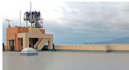
屋上および無線塔
