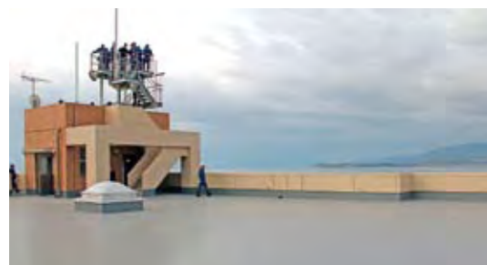
屋上および無線塔
