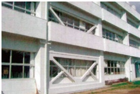
耐震補強工事後
