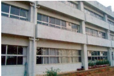
耐震補強工事前
