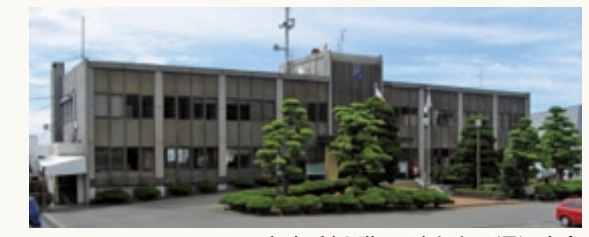
事務所(2階のみ)となる深江庁舎
