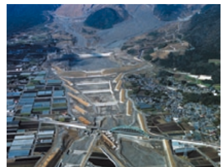
導流堤で町が守られているのがよくわかる 【国土交通省雲仙復興事務所撮影】
