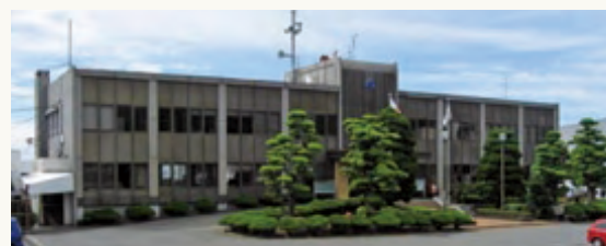
事務所(2階のみ)となる深江庁舎
