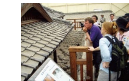
土石流被災家屋保存公園(深江町) 平成噴火の土石流で埋没した家屋を保存、展示しています。
