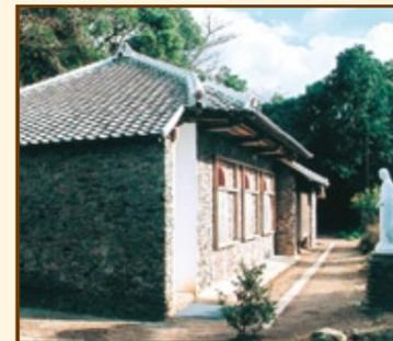
ド・ロ神父の設計・指導によって出津教会の巡回教会として建てられた、玄武石を外壁にした和瓦葺きの建物。赤土を水に溶かした濁液で砂と石灰を混ぜ、石材を積み上げるド・ロ壁を用い、信徒の奉仕で完成した。山中にひっそりと立ち、風土に密着した素朴な雰囲気と雅趣がある。
