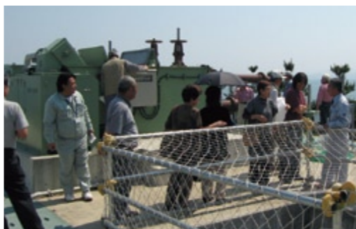
整備された下水道施設。出前講座も受け付けています。
