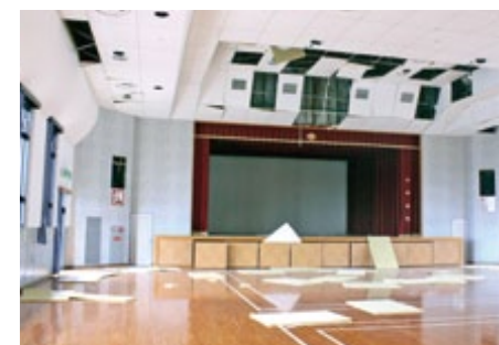
北有馬ピロティー文化センター日野江の吊り天井パネルが落下
