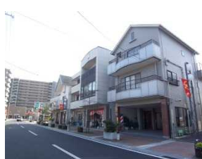
建物の正面の外観や高さを統一した例
